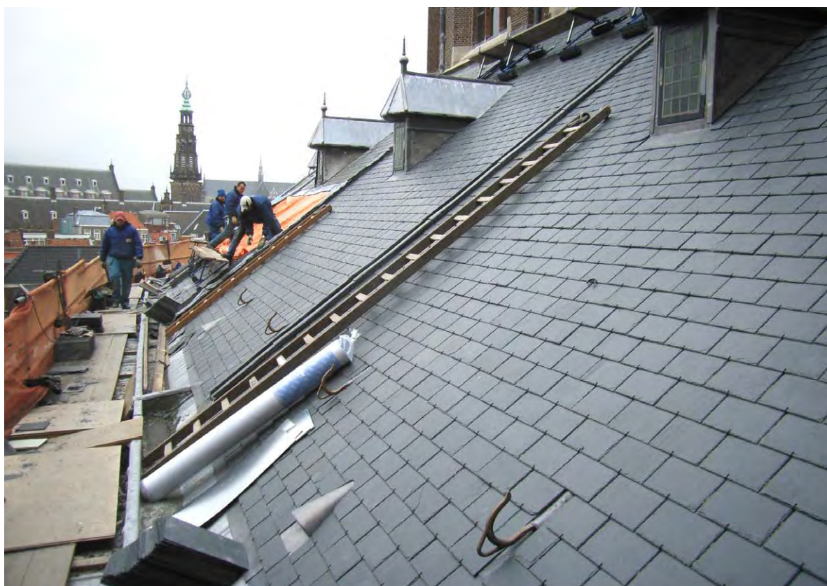
Restauratie van dakvlak in Maasdekking. (foto: E.J. Nusselder)
